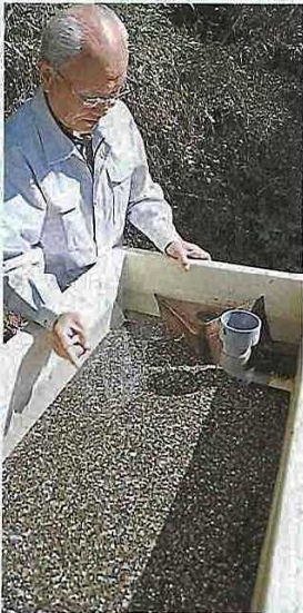
①昨年3月に設置された簡易濾過装置。手前で荒濾過、真ん中でさらに濾過され、奥のタンクにためられる宇佐市内町羽馬礼②砂利が敷き詰められた荒濾過装置について説明する加藤幹雄さん。宇佐市内町和田
